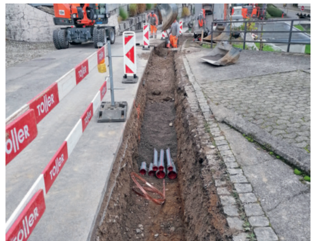
Werkleitungen an der Hirzlistrasse
